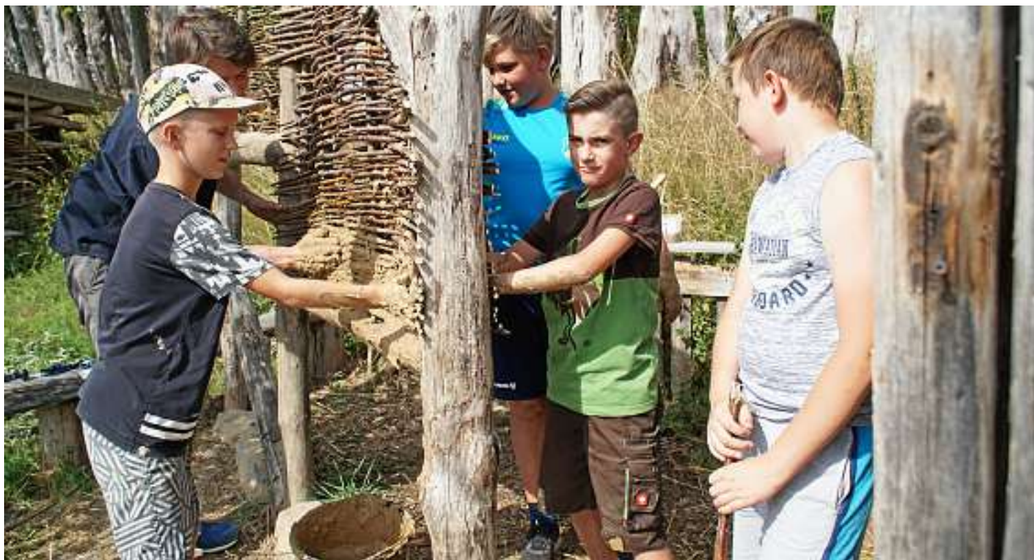
Nick Petukat von der Uni Jena probiert mit Lenno Lumnitz, Tom Jüngling, Paul Lewin Werner und Felix Lange (von links) aus, wie eine Wand aus Reisig und Lehm gebaut werden kann.
